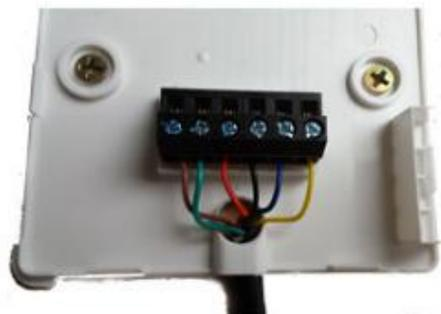
安装(86 安装)好底壳，按线序接好接线
